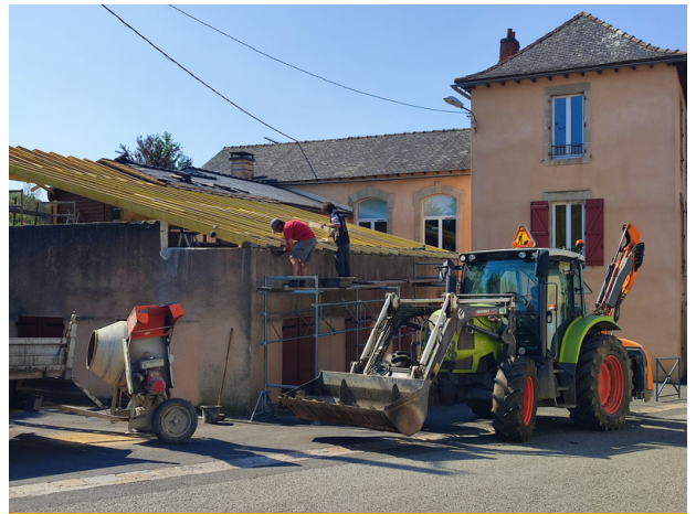
travaux sur le toit de la cantine
