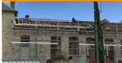
pose de volets
