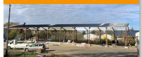
montage du hangar de stockage (déc. 2023)
